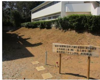
施工場所 (構内の実斜面)
