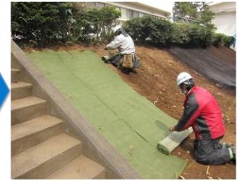
植生シート敷設 (緑化ネット, 流動防止シート)
