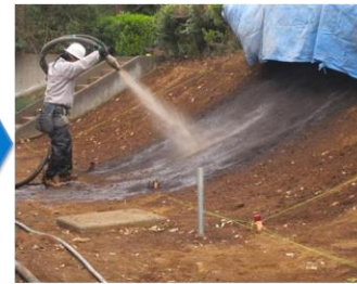
吹付工 (痩せ地, 硬質土, 岩盤等)
