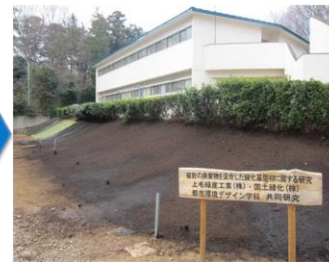
施工場所: 吹付後 (のり面流動防止)
